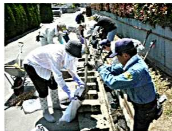
なれない作業に四苦八苦！！
